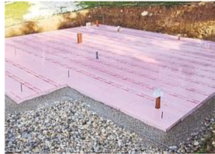
Schüttung unter der Bodenplatte
