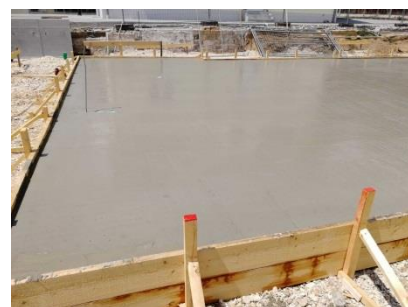
Die Entwässerung verlegen und die Bodenplatte betonieren
