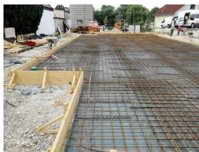
Die Entwässerung verlegen und die Bodenplatte betonieren
