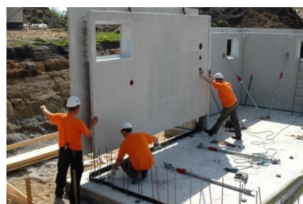
Aufstellen von Fertigteilen im Keller
