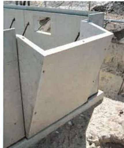
Der Lichtfluter wird als Fertigteil geliefert und gleich bei der Kellermontage mit eingebaut. Er wird abgedichtet und entsprechend den energetischen Anforderungen umlaufend gedämmt.
